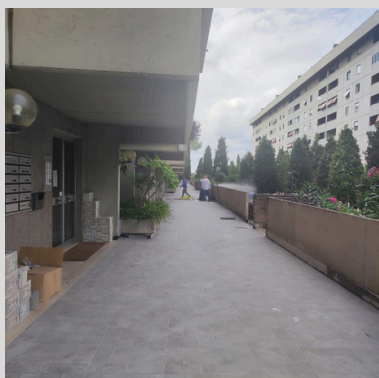
Pavimentazione area condominiale
