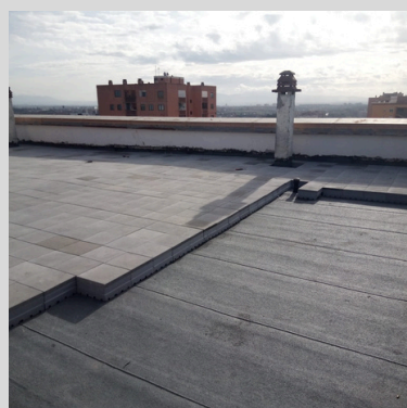
Rifacimento lastrico solare, guaine e posa pavimento flottante
